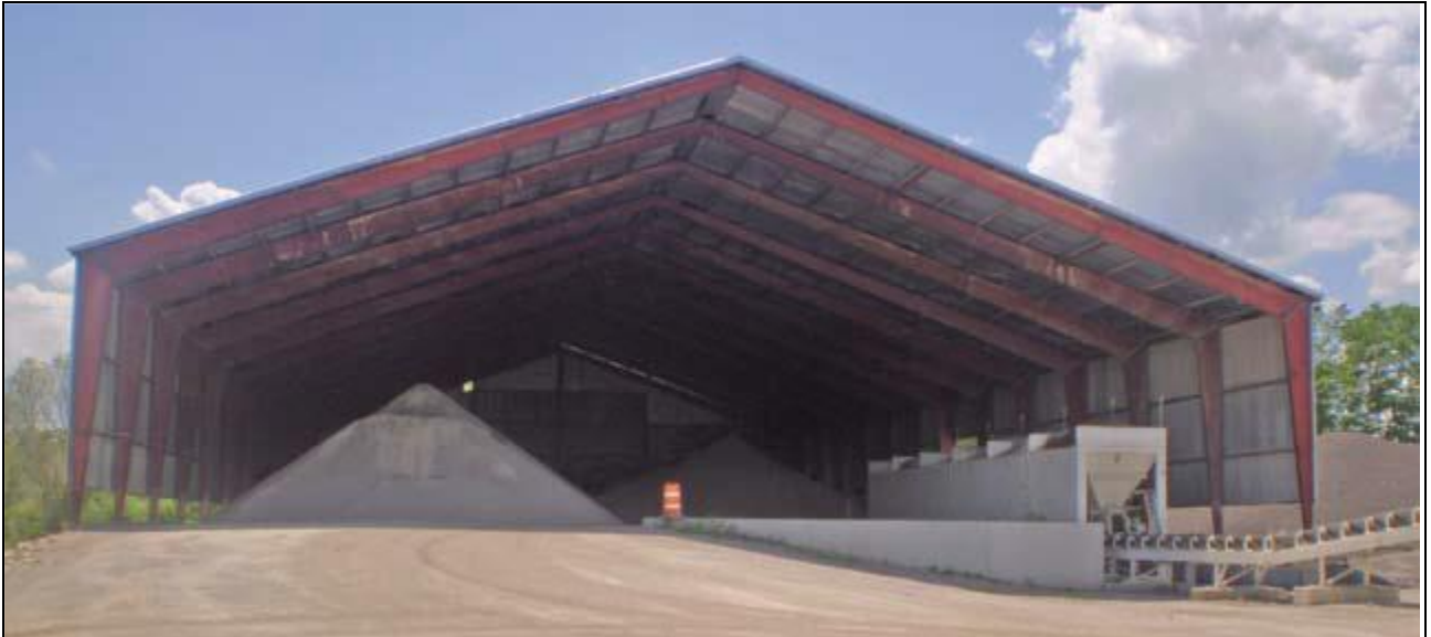
Figura 2 - Exemplo de depósito de agregados coberto (NAPA, 2012)
